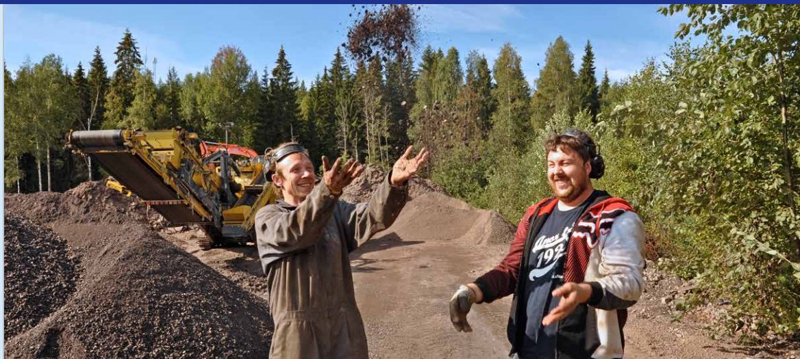
Återvinning. Mikael Hedberg och Mattias Johansson kastar upp asfaltsmaterialet som är klart för nya asfaltsbeläggningar.
