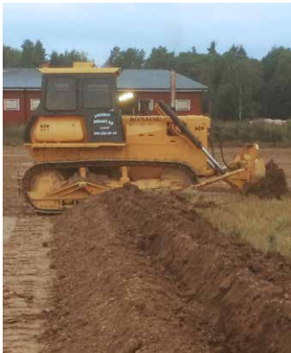
Arbetet med det nya grishuset har kommit i gång.
