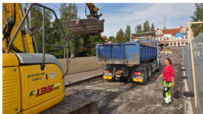
DalaFrakt i samband med renoveringen av Leksandsbron.
